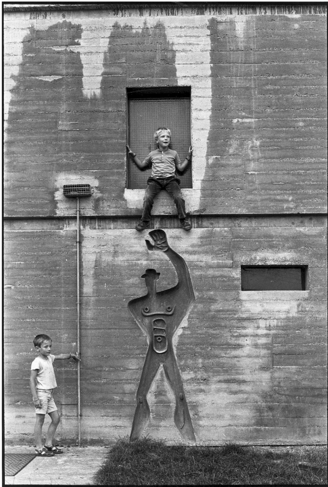
Empreinte du Modulor dans le béton, Unité d'habitation de Rezé, Nantes. J. ACH, FLC, ADAGP, PARIS 2015/DR
